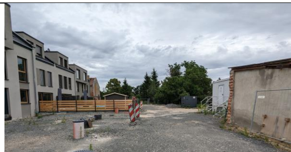
Abbildung 4: Bestand & Erschließung von Westen (Quelle: eigene Aufnahmen, 07/2023)
